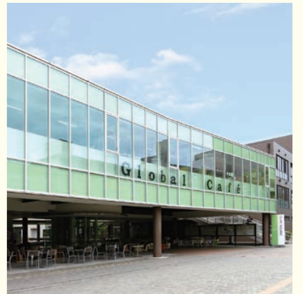
グローバルカフェセンター北側外観
