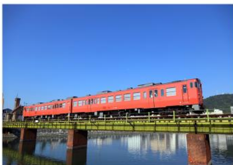
牟岐線 新町川橋梁
