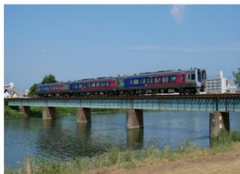
高德線 春日川橋梁
