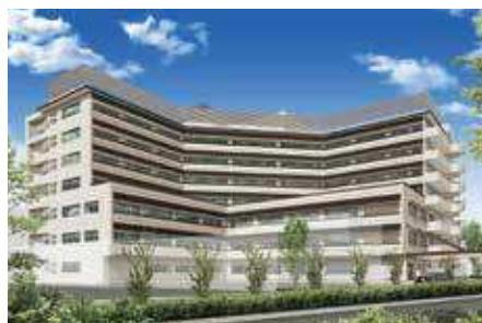
平成26年夏に運用が開始される新病棟は、 地域の医療を支える最新の設備が整っています。
