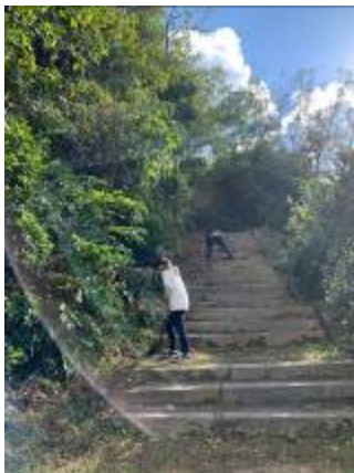
階段整備の様子
